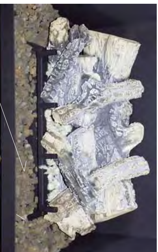
Étape (10) Placez les pierres concassées sur le plancher de la chambre de combustion. (N.B. Ne pas placer de pierres sur les tubes de brûleurs)
