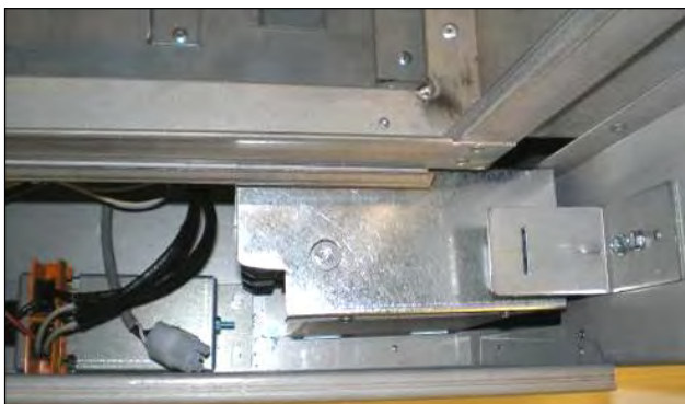
Module de contrôle de l'évent installé dans le foyer (VUE DE DESSUS).
