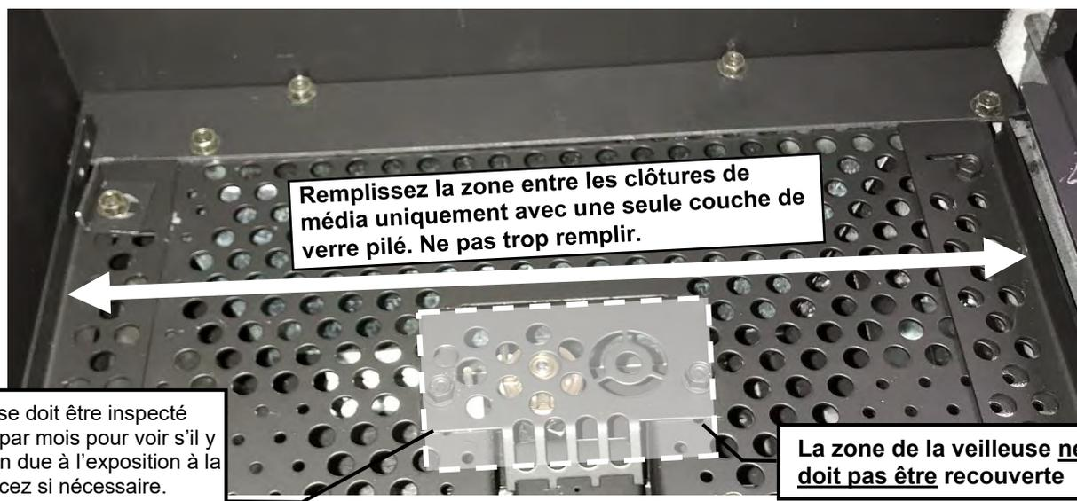
\*L'écran de veilleuse doit être inspecté visuellement une fois par mois pour voir s'il y a signe de détérioration due à l'exposition à la flamme. Remplacez si nécessaire.
