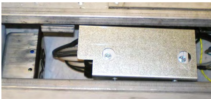
Module de contrôle de l'évent installé dans le foyer .
