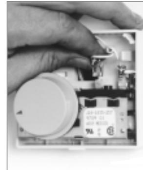
Tirer le fil par l'ouverture. Enlever le couvercle sur le panneau de contrôle et faire passer le fils de l'arrière du contrôle. Fixer le contrôle sur le mur. Enlever les bornes du déshumidistat et brancher aux fils électriques. Glisser les bornes sur les lames.
