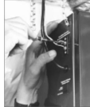
À l'aide d'un tournevis mince, relier les deux fils électriques aux bornes du contrôle de déshumidification, à l'extrémité de l'appareil. Faire passer les fils électriques dans le mur, jusqu'à la position centrale du contrôle de déshumidification. On peut utiliser du fil supplémentaire si les fils fournis ne sont pas assez longs. Faire les raccordements des fils avec des connecteurs.
