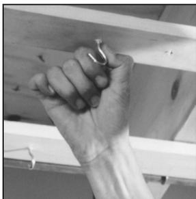
**1** Posez les crochets de fixation sur la fourrure ou les solives de plancher.
