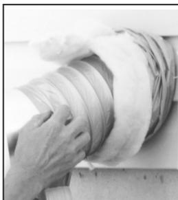
**2** Faites passer le conduit flexible isolé dans l'ouverture jusqu'à ce qu'il soit bien tendu et droit. Faites glisser le manchon en vinyle interne du conduit sur le collet de la hotte et fixez-le; recouvrez le conduit de l'isolation puis posez le pare-vapeur sur le manchon; fixez à l'aide de ruban adhésif en toile.
