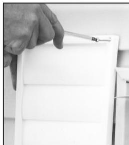
**3** Enfoncez la hotte dans l'ouverture. Fixez la hotte sur le mur extérieur en utilisant des vis de montage. Répétez la procédure d'installation pour la hotte d'aspiration et la hotte d'évacuation.
