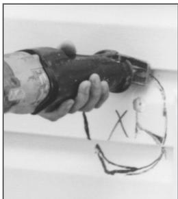
**1** Tracez le contour du collet de la hotte externe pour couper les trous d'aspiration et d'évacuation. Le diamètre des trous doit être un peu plus grand que celui du collet pour tenir compte de l'épaisseur du conduit flexible isolé. Percez un trou pour la hotte d'aspiration et la hotte d'échappement.
