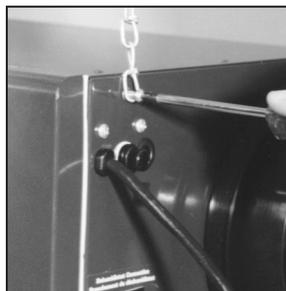
**2** Suspendez la chaîne (fournie) à chaque boulon de 19 mm (10-32 x 3/4 po) (fournis) situés aux quatre coins supérieurs du VRC et serrez.
