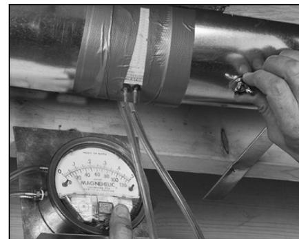
**3** Le débit d'air est régulé à l'aide d'un registre d'équilibrage situé à l'intérieur du collet du VRC. Réglez le registre « Supply Air Out » (sortie de l'air fourni) de façon à obtenir le débit d'air désiré. Suivez les étapes précédentes afin de régler le registre « Exhaust Air Out » (sortie de l'air vicié).
