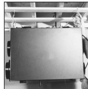
**3** Suspendez le VRC en faisant glisser un maillon de la chaîne dans les crochets de suspension et assurez-vous que l'appareil est de niveau.
