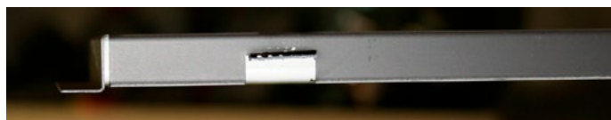
Figure 4.d Bas de la rallonge de la bride de clouage avec une languette pliée à 90 degrés
