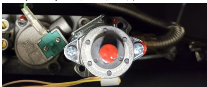
Figure 13.eee Régulateur de pression du pétrole liquéfié sur un modèle à pleine charge
