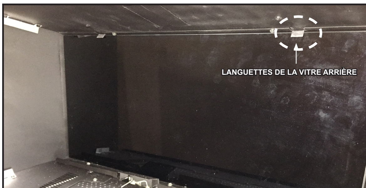
Figure 5 Installation du panneau de verre arrière
