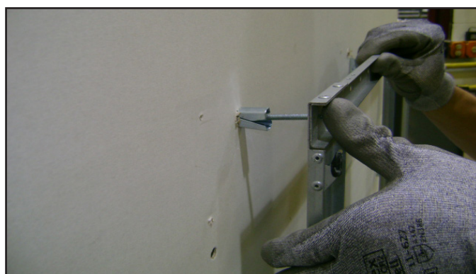
Figure 4.11 Installation des ancrages dans une cloison creuse
