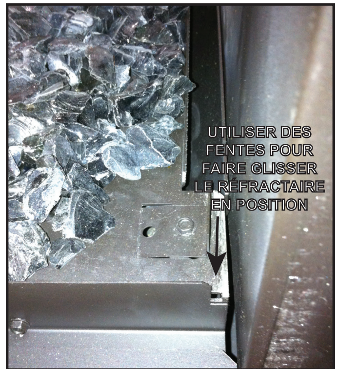
Figure 9.7 Installation du réfractaire
