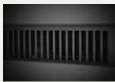
Ouvertures de ventilation
