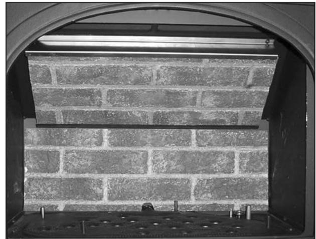
Figure 63: Panneau de brique arrière en place.
