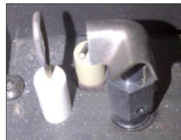
Figure 10: Position correcte du pilote
