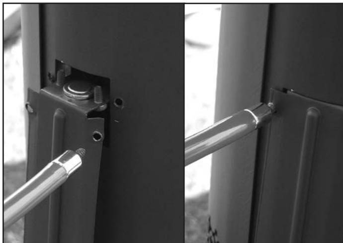
Figure 48: Installation de l'interrupteur de déversement.
