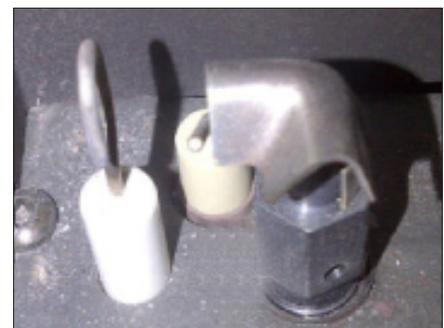
Figure 20: Position correcte du pilote
