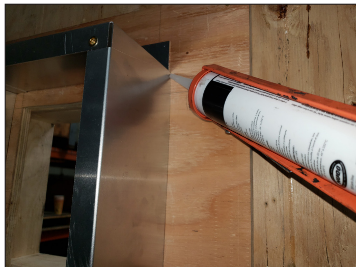
FIGURE 2.7 Appliquez le scellant silicone tout autour (en périphérie)
