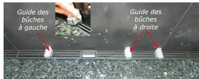
Guides des bûches installés
