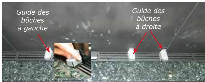
Guides des bûches installés
