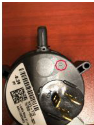
Pressostat côté "P"
